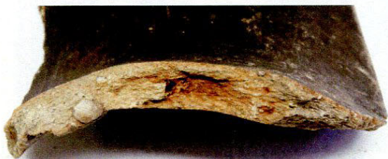
2. 黒色物塗布 内部には浸透しない (納所)
