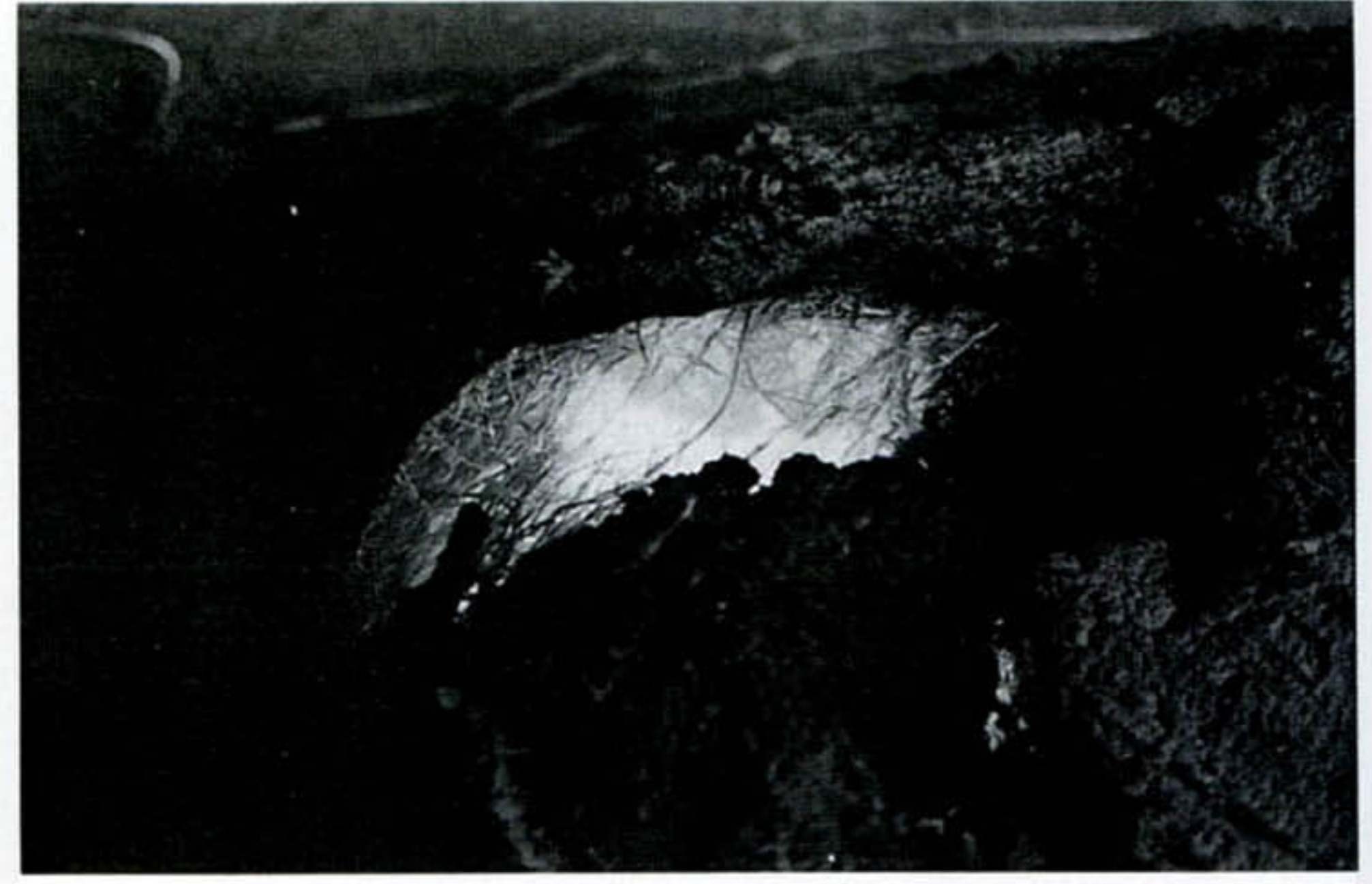
20 頂部に生じたひび割れから内部を見る 全体にほぼ均一に赤く発色している。基本的 にいずれの実験についても同様の現象が 起こっている
